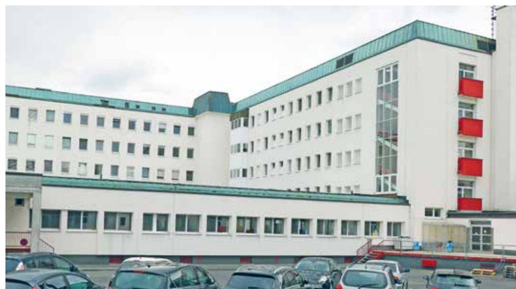
Die Bausubstanz der Kreisklinik - unser Foto zeigt den Betten- und OP-Trakt von der Westseite - ist gut. Sanierungs-Maßnahmen sind hier nicht notwendig. Foto: pem
