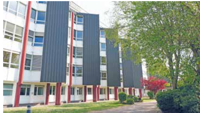
Die Fassade des Bettentraktes der Kreisklinik auf der Südseite: Die vor rund 20 Jahren angebauten „Nasen“ werden verschwinden; Dafür sollen neue Nasszellen mit duschen für jedes Zimmer angebaut werden. Foto: pem
