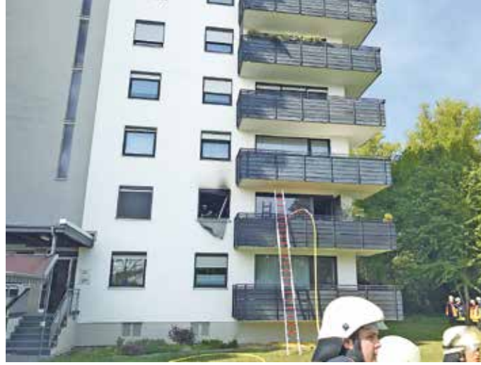
Glimpflich verlief ein Feuer im Hochhaus in der Thomas-Mann-Straße: Der Brand konnte rasch gelöscht werden, Menschen wurden nicht gefährdet.
